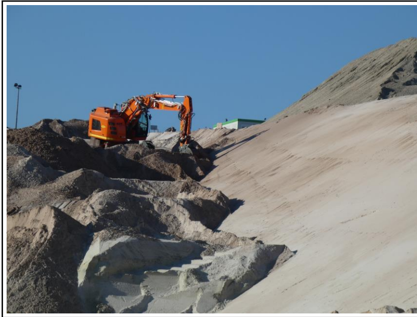
Extraction des matériaux et travaux de terrassement latéraux des talus de la carrière pour la réalisation des casiers (septembre 2023).
