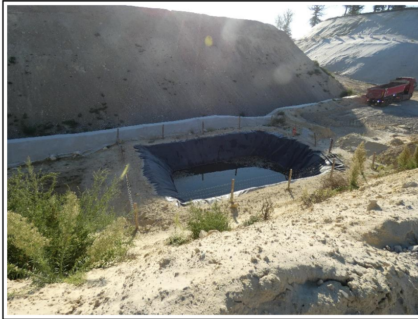
Bassin de collecte des lixiviats (septembre 2023).
