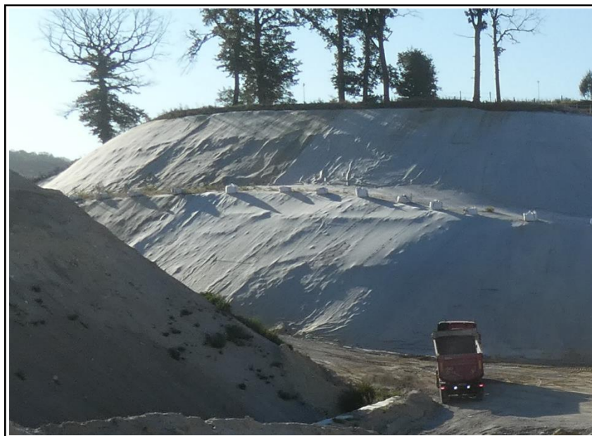
Vue du flanc du casier Sud recouvert par le Géocomposite Synthétique Bentonitique (GB) (septembre 2023)
